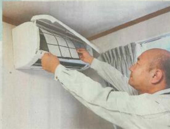
エアコンフィルターの清掃作業をする杉本さん（浜松市内）
